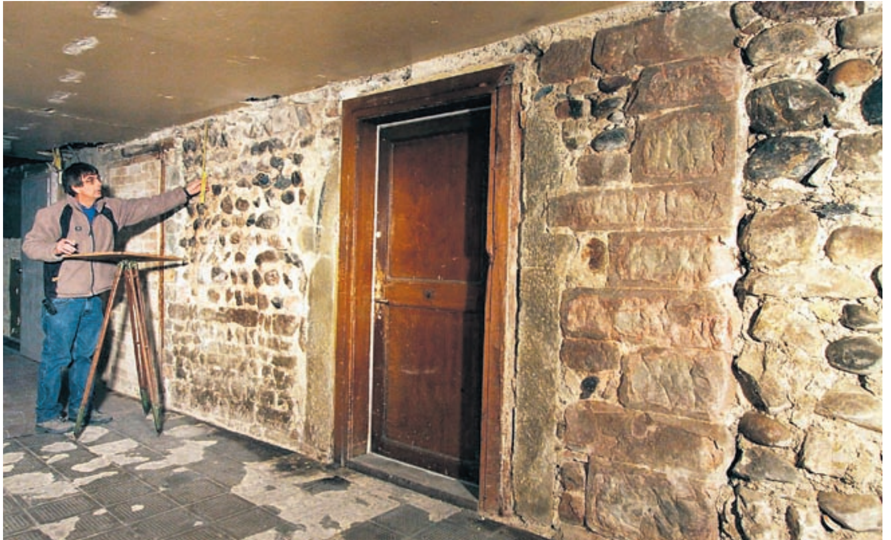
Roman Szostek sucht Spuren der Vergangenheit und wird fündig: Im «Bauhof» zeigen rote Verfärbungen an der alten Mauer, dass es im 13. und 14. Jahrhundert brannte. Bild: pd
